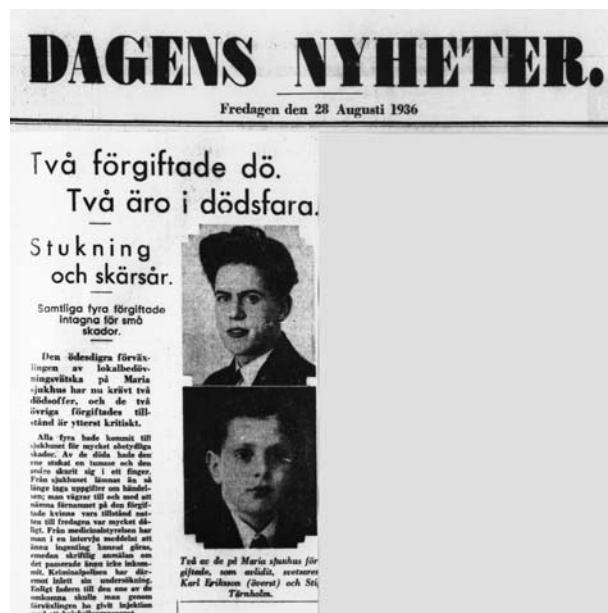
Bild 2. Dagens Nyheter's förstasida fredagen den 28 augusti 1936 där de två första dödsfallen vid Maria sjukhus rapporteras. Foto: Kungliga Biblioteket
